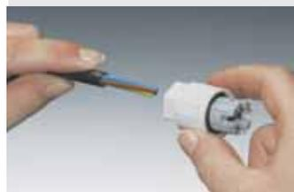
Glisser l'écrou de distribution sur le câble dégainé, jusqu'à la butée
