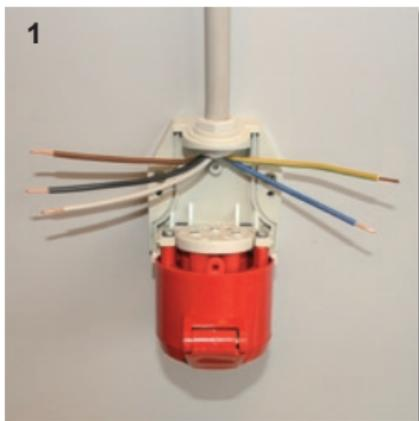
Retirer la gaine extérieure du câble et insérer le à travers le passe câble du boîtier. Puis dénuder les conducteurs.
