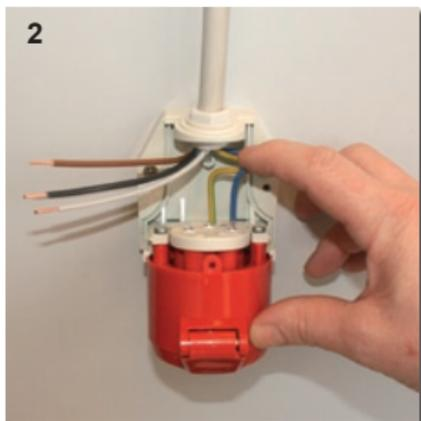
Plier et insérer les conducteurs l'un après l'autre dans les contacts associés, jusqu'à la butée.
